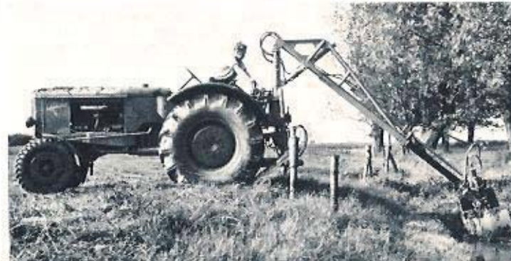
Beim Einsatz mit dem Grabenbagger
