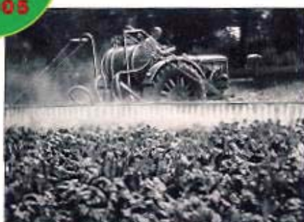
Schädlingsbekämpfung in hohem Rübenkraut mit einem 10 m breiten Sprüh- und Spritzgerät.
