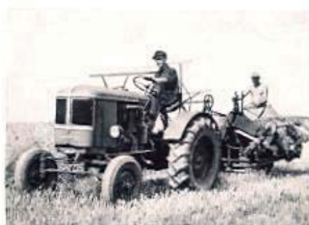
Ernten mit einem 7 Fuß breiten Zapfwellenbindemäher im robusten Tag- und Nachtbetrieb.
